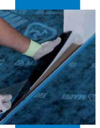
Desenrollar Mapesilent Roll colocándolo en la base de la pared y extenderlo con la capa fibrosa (parte clara) hacia abajo, siguiendo el lado más largo de la habitación. Extender el segundo rollo colocándolo en la base de la pared procurando eliminar la película de la pestaña lateral para superponer al rollo adyacente (aproximadamente 5 cm) a fin de garantizar la continuidad de la capa fibrosa
