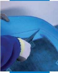
Cortar Mapesilent Band R (o Mapesilent Band) por la parte inferior, de manera que se pueda crear un ángulo de 90°
