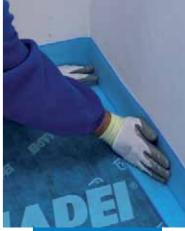
Juntar los rollos de Mapesilent Band R (o Mapesilent Band). Eliminar la película adhesiva protectora y pegar por todo el perímetro del local
