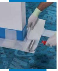
Cortar y aplicar Mapesilent Tape en el ángulo y sobre todos los puntos de unión y sobre todas las superposiciones entre Mapesilent Band R (o Mapesilent Band) y Mapesilent Door para garantizar una perfecta protección de las juntas
